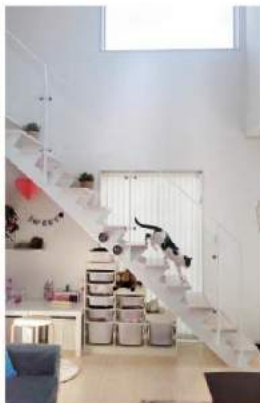
同社オリジナルの、オープンタイプの3ミリ桁と段板が射入る美しいシルエット(F氏邸) (参考価格: 1,042,000円)
