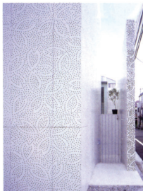
MOUNT FUJI ARCHITECTS STUDIOの最新作「SAKURA」。ステンレス板に無数の穴をあけ、伝統的な桜の小紋柄を表現した壁が特徴的な住宅である。積極的に協力してくれる工場があってこそ、アイデアが実現した。写真：新良太
