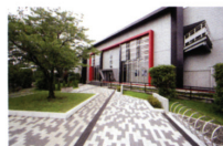
埼玉県栗東市にあるカツデンアーキテック工場。建築そのものもスマートで目を惹く。
