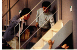
ついついディテールに目がいってしまう。段板を取り付ける金具の溶接跡がほとんど分らないことに驚く。従来のスチール製の階段のイメージとは、まったく違う美しさがある。ジョイント部分の改良は常に続けている。
