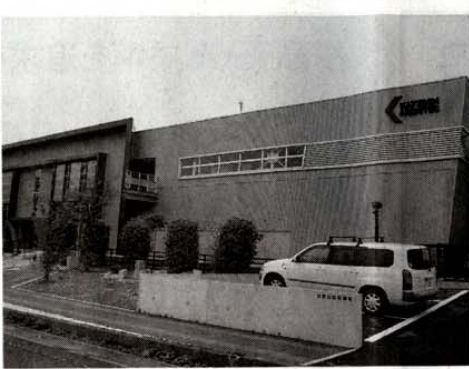
団地工場(埼玉県玉郡美里町)
