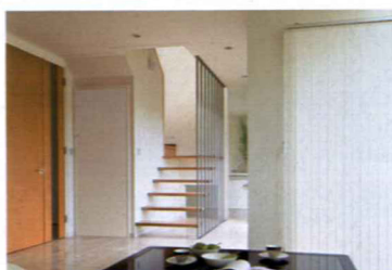
段板を壁面と手すりに固定した「FRIS」。扉と段板の色をコーディネートし、手すりはシルバーに。
