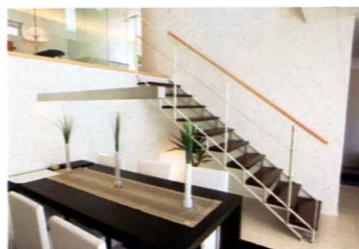
手すりやささら桁を白く塗った「シースルー階段」。白基調のインテリアに異和感なくマッチしている。
