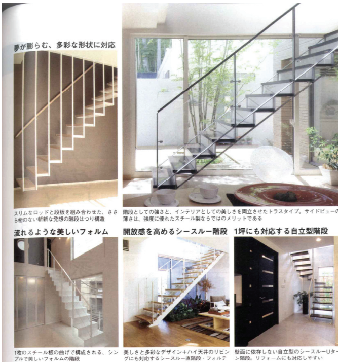
1枚のステンール板の曲げで構成される、シンプルで美しいフォルムの階段
