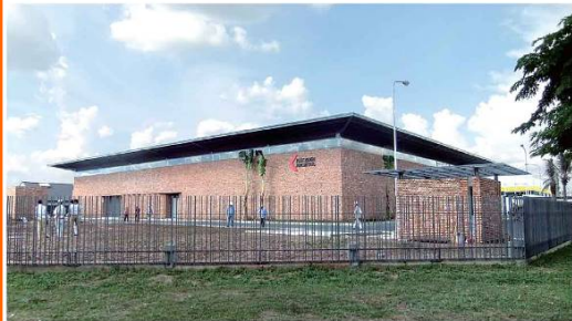
板金加工と溶接、塗装を一貫対応する
